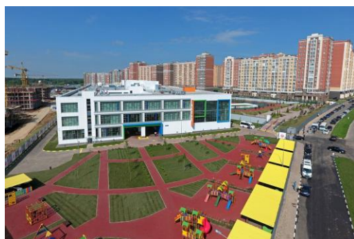
Рис. 3 - Комплекс детских площадок на территории ГБОУ СОШ «№ 2070 имени Героя Советского Союза Г.А. Вартаняна» г. Москвы [1]
